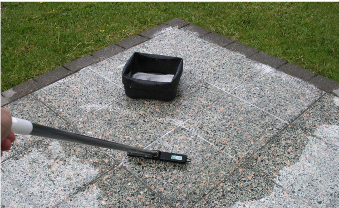
Bild 2: Die Essigessenz-Lösung wird auf der Oberfläche mit einem Schrubber verteilt.
