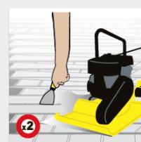
Verdichten Sie das Fugenmaterial, indem Sie den Belag mindestens zweimal mit einer Rüttelplatte bearbeiten. Versehen Sie die Rüttelplatte mit einer Gummimatte, damit der Belag nicht beschädigt wird. Kontrollieren Sie mit einem Spachtel, dass die Fuge fest verdichtet ist. Man darf den Spachtel nur wenige mm in das Fugenmaterial pressen können.
