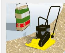
Um eine kompakte und solide Oberfläche zu erhalten, muss der Belag verdichtet werden. Bei trockener Witterung sollte die Wegedecke zunächst mit einer Gießkanne oder einem weichen Wasserstrahl angefeuchtet werden.
